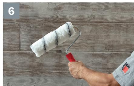
Après séchage complet, appliquer **Baunit Lasur** (min. 0,1 L/m<sup>2</sup>) dans le sens du motif avec un rouleau polyamide 10-12 mm. Estomper le surplus de lasure avec un chiffon.
