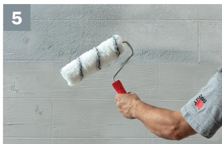
Appliquer **Baunit StarColor** (min. 0,2 L/m<sup>2</sup> par couche) dans le sens du motif avec un rouleau polyamide 10-12 mm.
