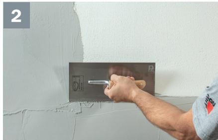
Après séchage complet, appliquer **Baunit CreativTop Silk** (min. 2 kg/m<sup>2</sup>) à l'aide d'une lisseuse inox en épaisseur d'environ 2 mm.
