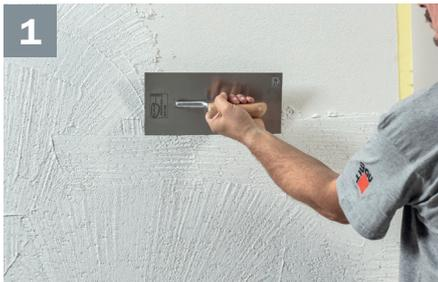
Appliquer **Baunit CreativTop Fine** (min. 2 kg/m<sup>2</sup>) à l'aide d'une lisseuse inox. Tirer simplement au grain sans talochage.
