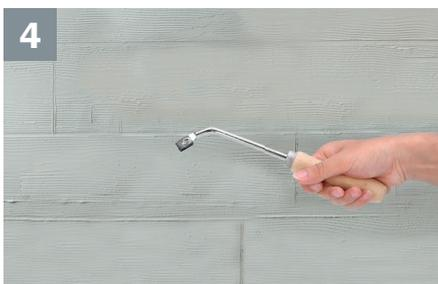
Après séchage complet, réaliser les joints à l'aide d'une gouge dans toute l'épaisseur de **Baunit CreativTop Silk**. Vérifier l'horizontalité et la verticalité des joints à l'aide d'une règle à niveau avant traçage.
