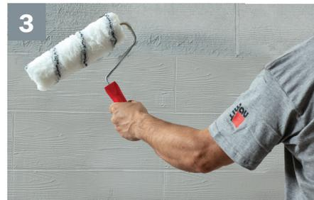
Après séchage complet, appliquer **Baumit StarColor** (min. 0,2 L/m<sup>2</sup> par couche) dans le sens du motif avec un rouleau polyamide 10-12 mm.
