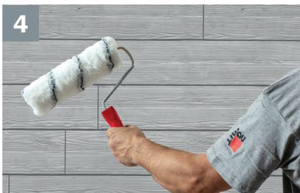
Après séchage complet, appliquer **Baumit Lasur** (min. 0,1 L/m<sup>2</sup>) dans le sens du motif avec un rouleau polyamide 10-12 mm. Estomper le surplus de lasure avec un chiffon.
