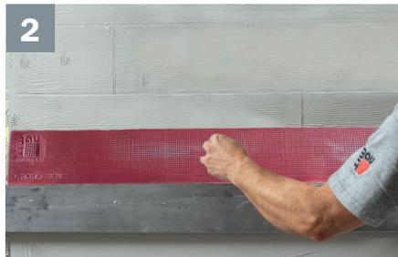
Immédiatement après application, imprégner la matrice silicone au rouleau avec **Baumit Separator** puis déposer la matrice sur la surface afin de structurer l'enduit.
