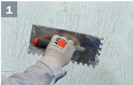
Appliquer **Baumit CreativTop Fine** (min. 4 kg/m<sup>2</sup>) à l'aide d'une taloche inox crantée U4. Lisser (sans talocher) à la lisseuse inox.
